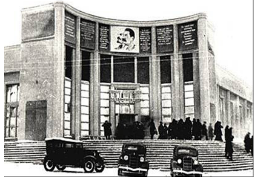
Здание кинотеатра «Октябрь» в 1938 г.
